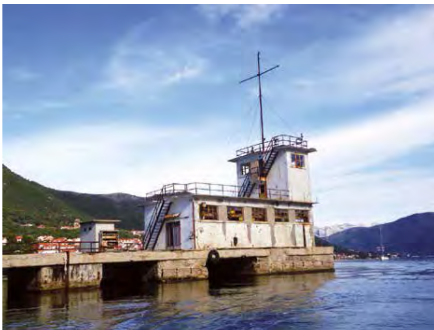
Lansirna stanica u Kumboru, srušena 2014.
