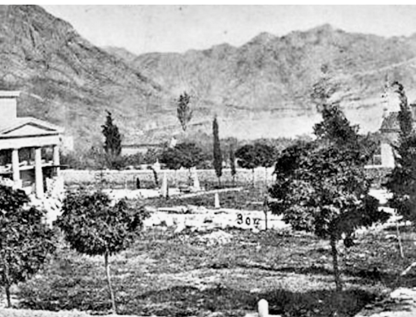
Kotorsko katoličko gradsko groblje, crkva sv. Mihovila u izgradnji oko 1867.
