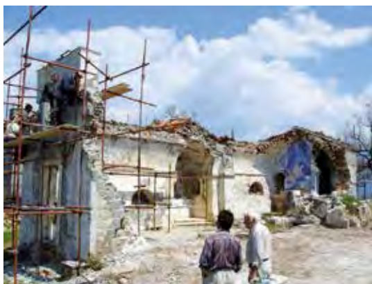
Crkva sv. Ivana u Bogišićima tokom radova
