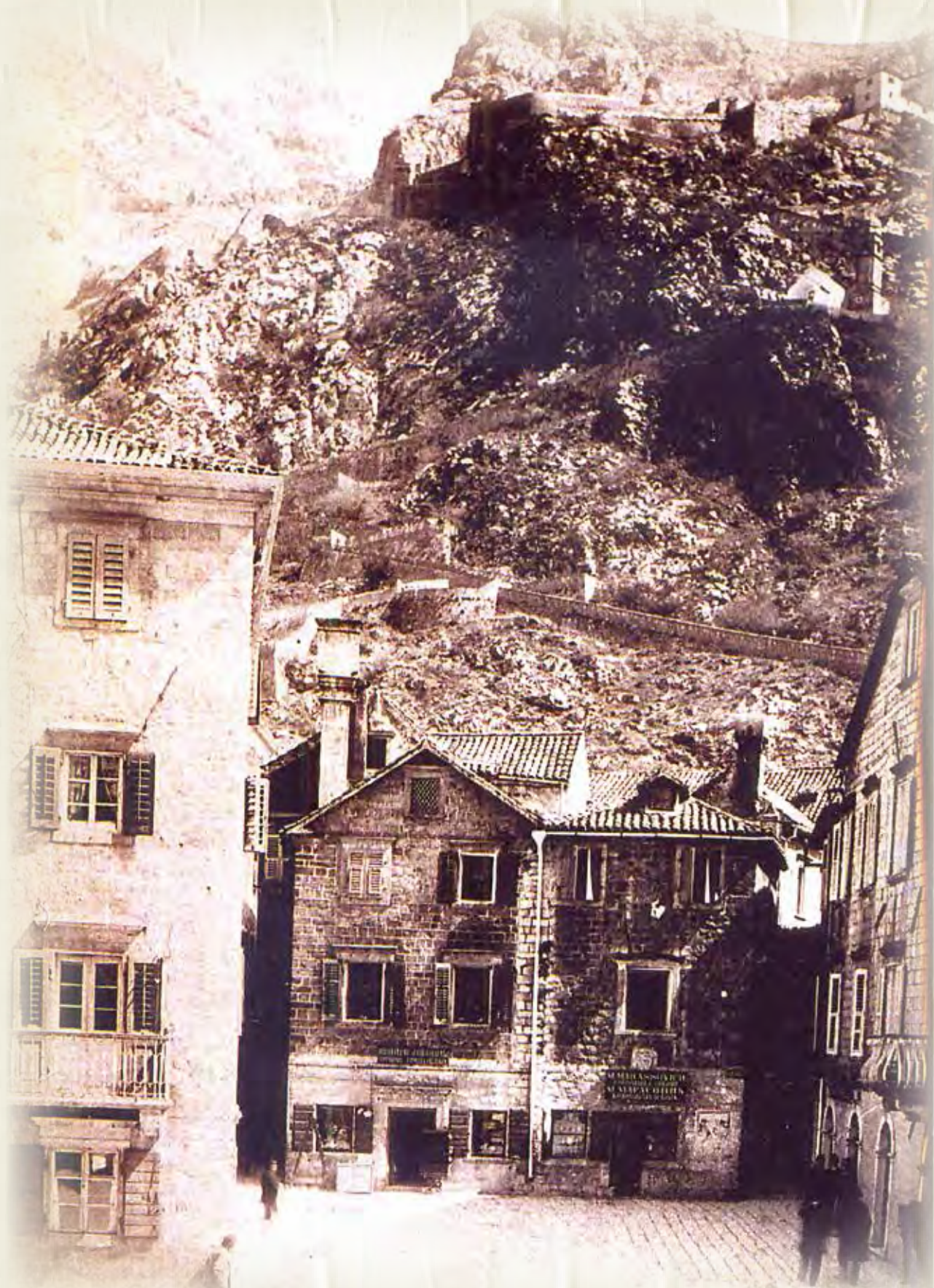
Prva lokacija HKD „Napredak“ u zgradi sadašnjeg hotela Vardar
