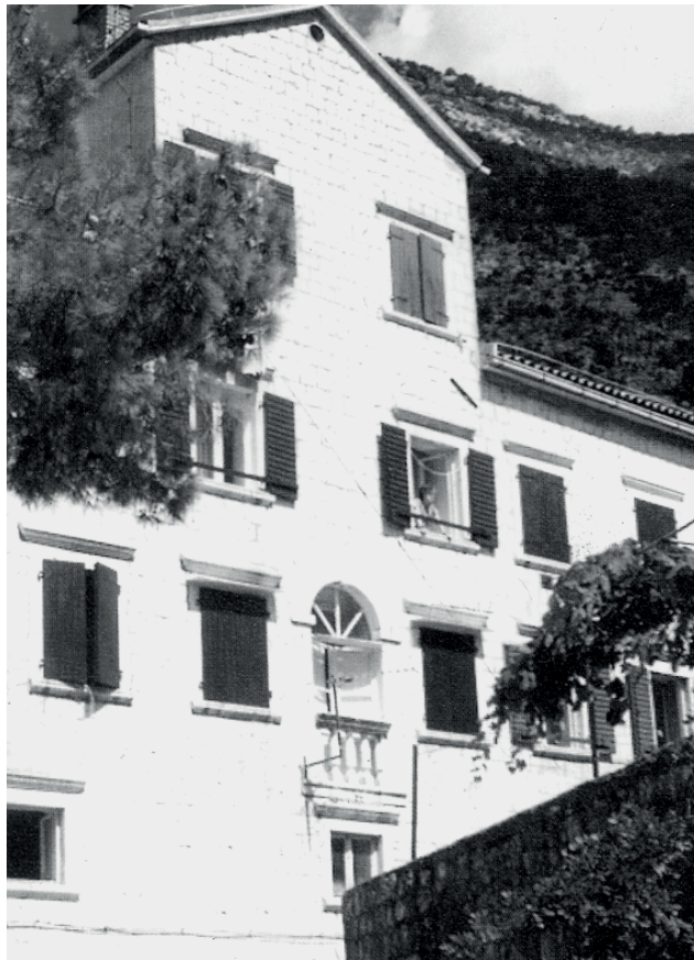
Zgrada na Prčanju u kojoj je Dom starih bio neposredno poslije II svjetskog rata
