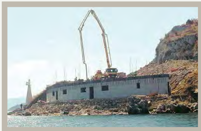
Gradnja na Turskom rtu
